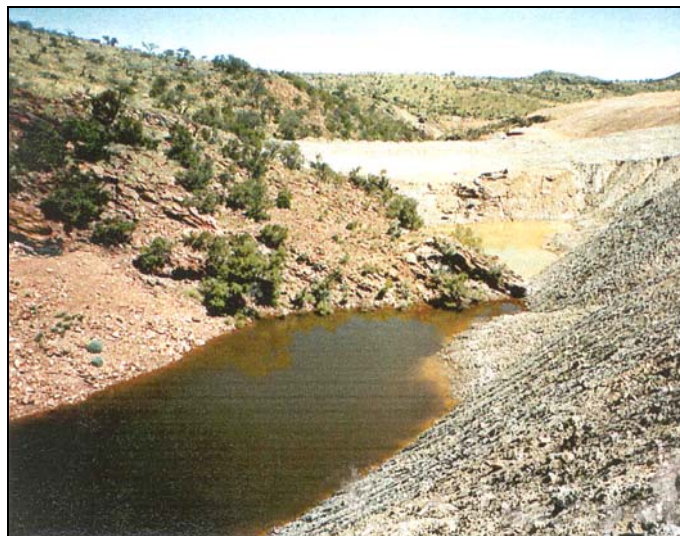
Abbildung 1: Saure Grubenabwässer sickern aus Aufbereitungsabgängen aus (Matchless Mine, Namibia); Foto: L. HAHN.
